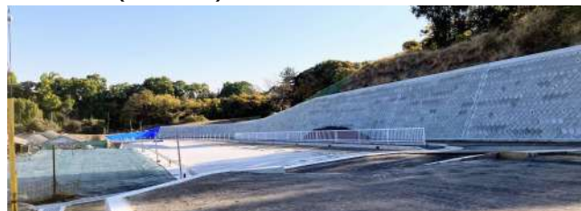
整備工事が進む御殿山小倉線（写真は浄水場側 12月10日撮影）
