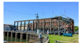
蹠跏ポンプ場
