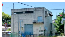
安居川ポンプ場
